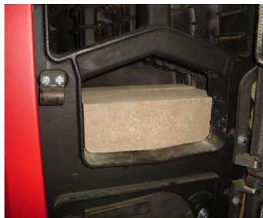
Rys. 11. Umieszczenie katalizatora ceramicznego na półkach wymiennika kotła KLIMOSZ MULTICOMBI.
