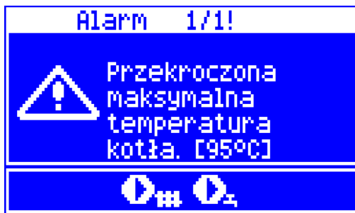
Rys. 44 Widok alarmu przegrzania kotła.
